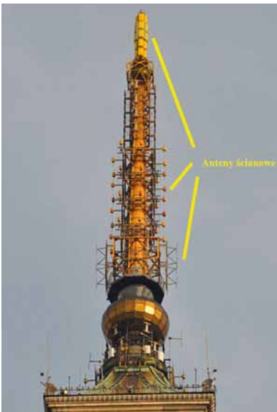
Ryc. 2.1. Iglica PKiN w Warszawie z widocznymi antenami ścianowymi
