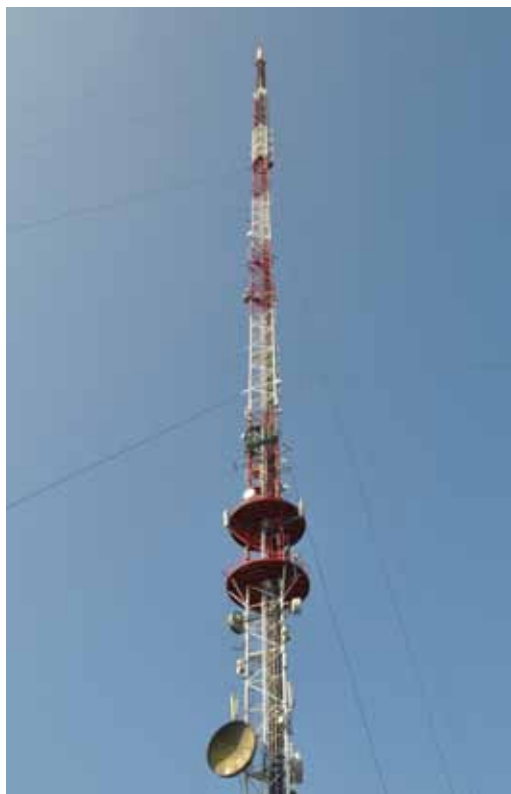
Ryc. 4.10. Radiowo-Telewizyjne Centrum Nadawcze Chorągwica. Pola elektromagnetyczne o poziomach wyższych od dopuszczalnych nie występują z reguły poza ogrodzonym terenem takich obiektów.
